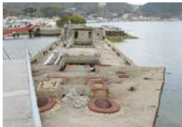
三津口港の防波堤として設置されている2艘の「武智丸」は、太平洋戦争末期の昭和19(1944)年、鋼材不足を補うため、兵庫県高砂市の造船所で建造されたコンクリートの船です。終戦時まで軍事物資の輸送にあたりましたが、終戦後の昭和24(1949)年、地元漁業者の要望により防波堤として設置されて以来、海の守り神として親しまれています。安浦の武智丸は、コンクリート船の原形を留めている全国的にも貴重なもので、数少ない戦争の語り部になっています。
